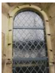
Nachzustand der Bleiverglasungen und der Eisen.
