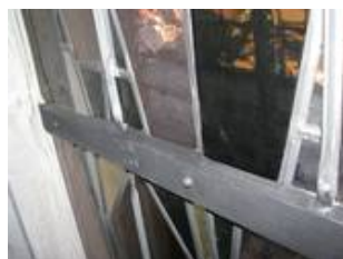
Nachzustand der Quereisen und des Dichtstoffes
