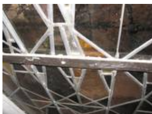
Vorzustand der Quereisen und des Dichtstoffes
