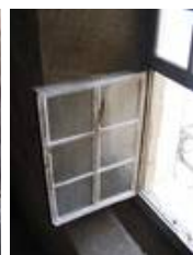
Vorzustand der Holzfenster, gut sichtbar, die teils stark abgewitterten Hölzer.
